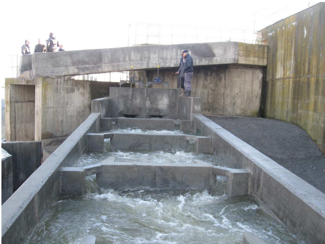
Figura 1. Imagen de la visita. Escala de peces de Villarlabo, la única en la cuenca de Duero con doble hendidura vertical.
